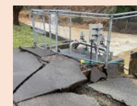
水道の復旧 (被災した浄水場)
